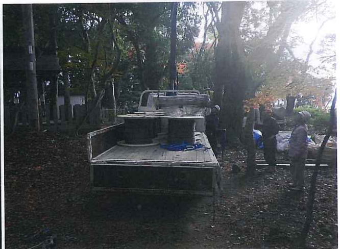
写真3 資材搬入状況
