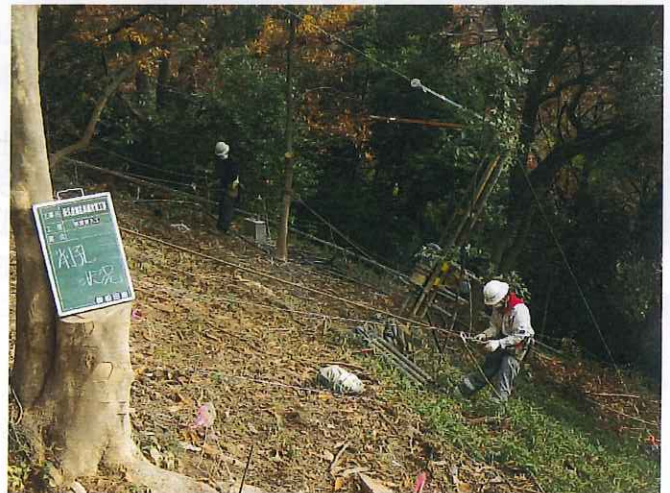
写真8 削孔状況
